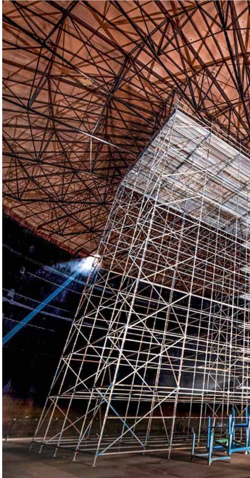
Gerüstbau in einem Lagertank
