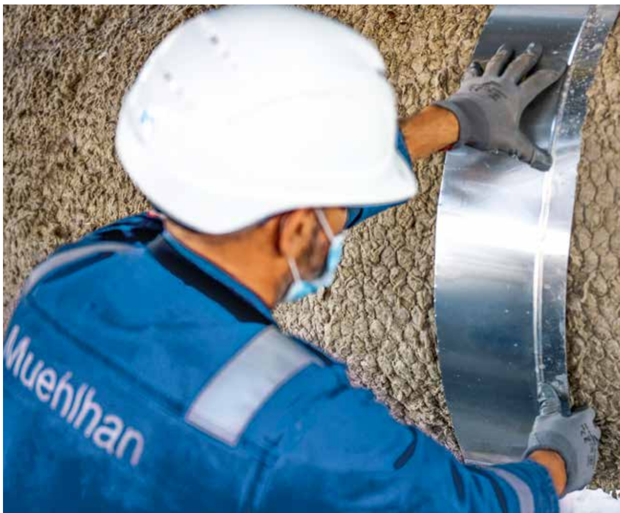
Aufbringen von Isolierung an einer Rohrleitung in einer Raffinerie
