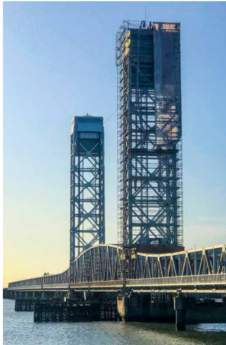
Korrosionsschutzarbeiten an der Rio-Vista-Brücke in Kalifornien, USA
