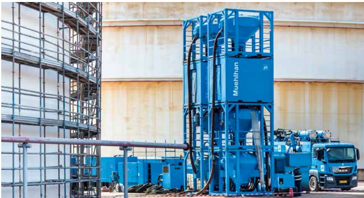
Strahlarbeiten an einem Lagertank
