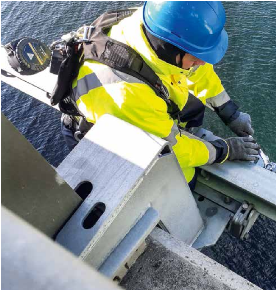
Arbeiten an der Öresund-Brücke in Dänemark
