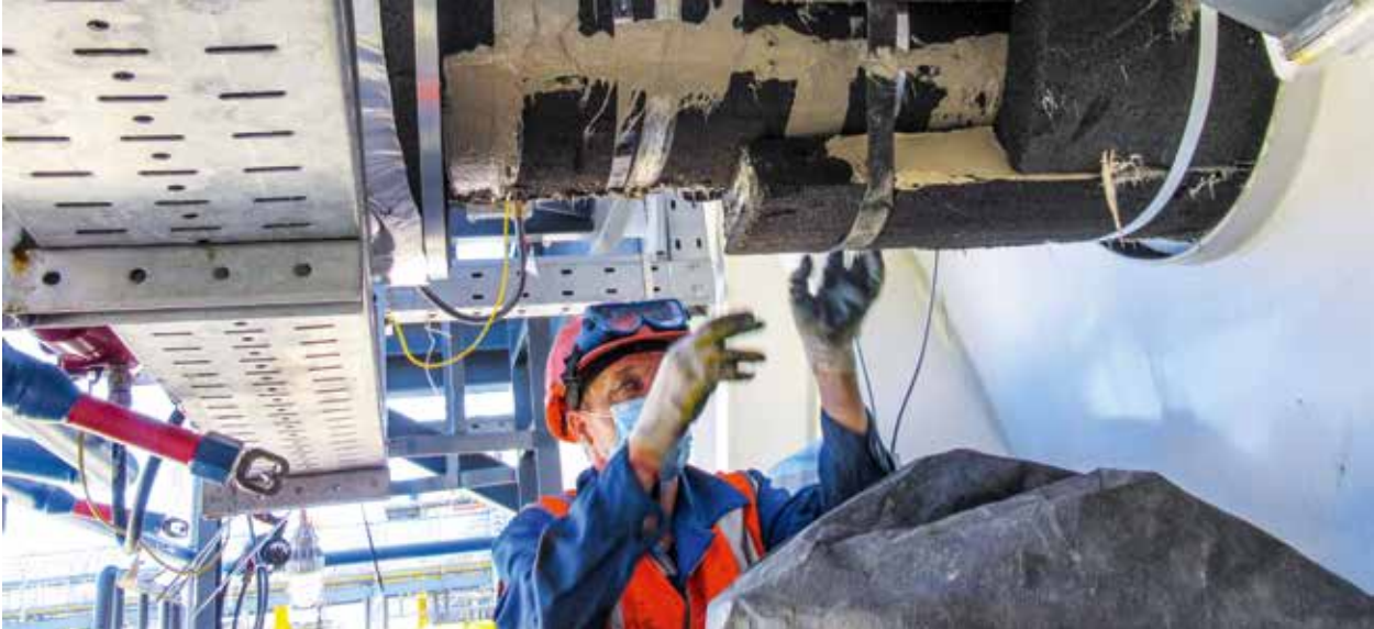
Isolierungsarbeiten an einer Gasverflüssigungsstation in Russland
